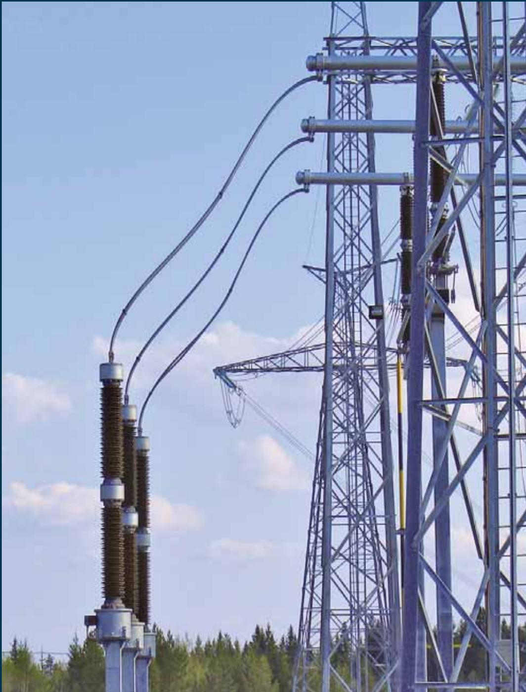
› Transformadores de tensión capacitivos de 420 kV. Fingrid, Visulahti (Finlandia).
