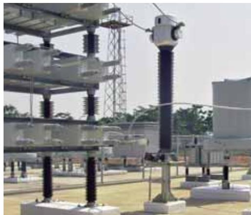
2. Transformador de intensidad de 245 kV protegiendo banco de condensadores (India).
