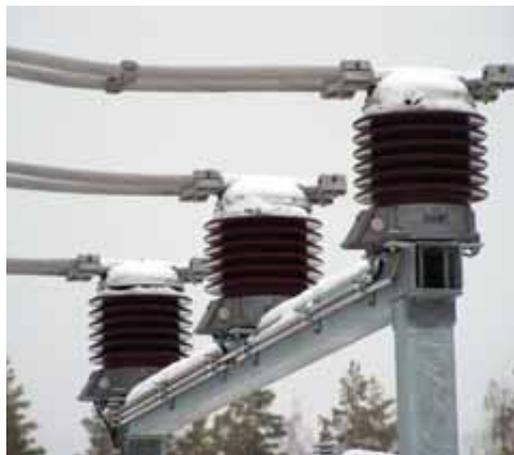
> Ensayo de tipo. CG 245 kV.
