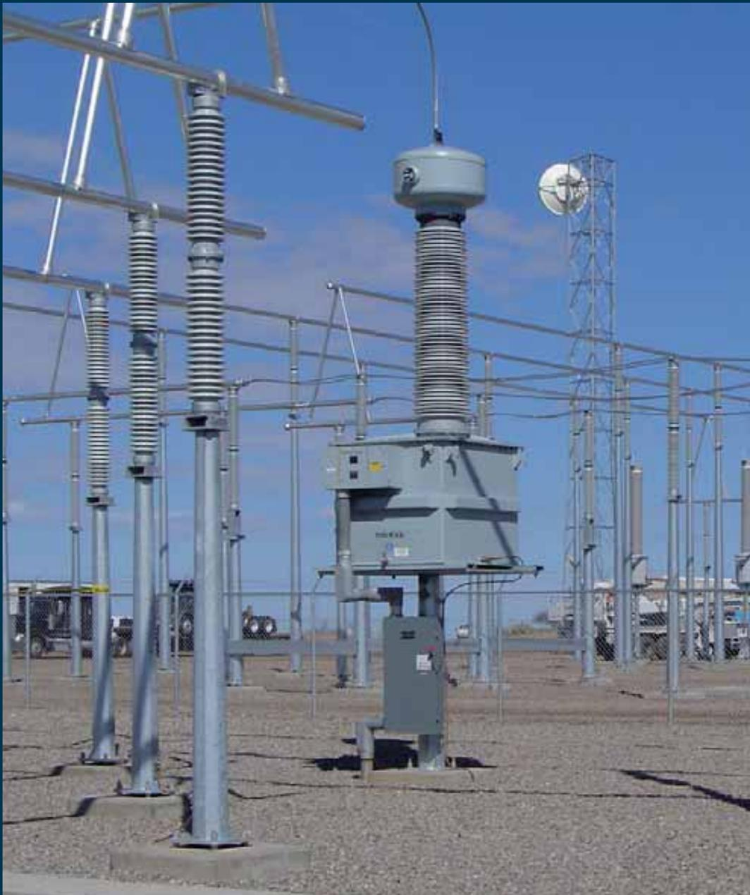
› Transformador para servicios propios de la subestación modelo UTP de 245 kV. Coyote Switch (Estados Unidos).
